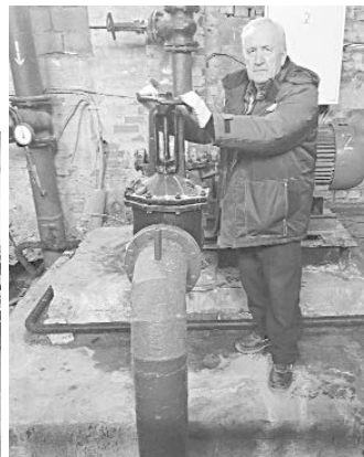
Анатолий ГОГИЧАЕВ при регулировке запорной арматуры
