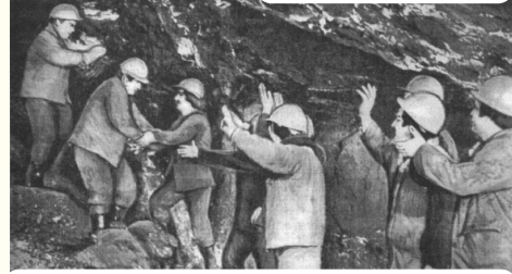
Сбойка Рокского тоннеля
