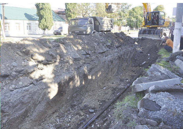
Замена газопровода по ул. Кучева
