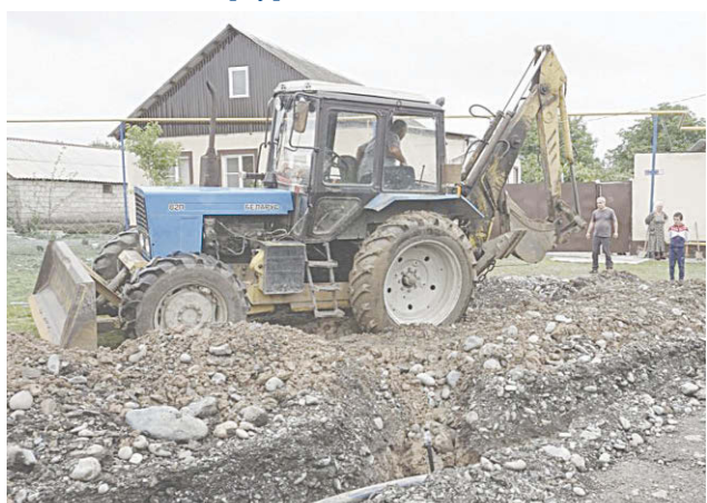
Реконструкция водопровода в с. Верхняя Саниба
